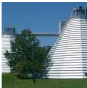
Kläranlage Gut Marienhof
