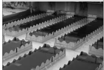
Ablaufsystem für Längsbecken.
