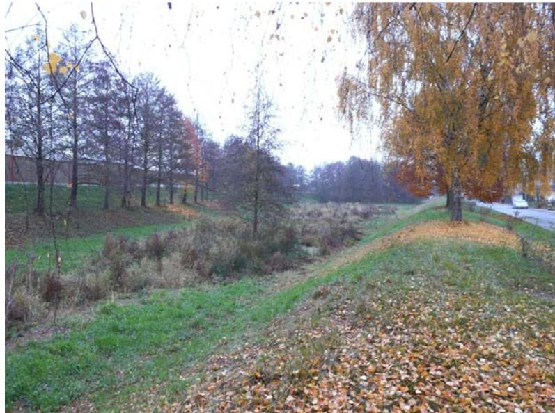
Abb. 2: Blick auf das HRB Kelleracker (Gemeinde Pfaffenweiler) mit integrierter Feuchtfläche; links hinter den Bäumen ist die Lärmschutzwand der Landesstraße L 125 zu erkennen, für deren Ausbau die Feuchtfläche im HRB als Kompensationsmaßnahme diente.
