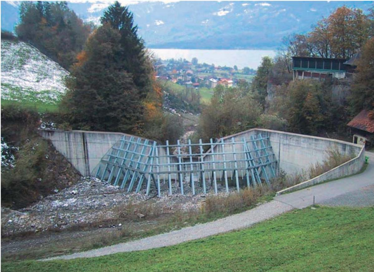
Abb. 7: Geschiebesammler mit Grobrechen für Schwemmholz von mehr als 2.5 m Länge im Oberlauf des Dorfbaches in Sachseln.
