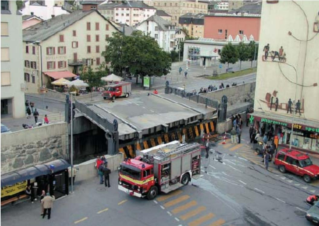
Abb. 9: Die Hubbrücke an der Saltina in Brig. Mit Stahlseilen verbundene Wasserbehälter füllen sich bei Hochwasser mit Wasser und heben die Brücke automatisch an. Damit bleibt genügend Durchflussprofil für Hochwasserspitzen.
