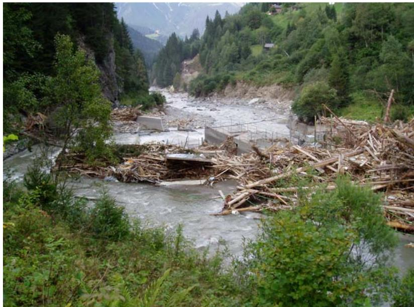
Abb. 19: zerstörte Fassung „Gfäll-Trisanna“
