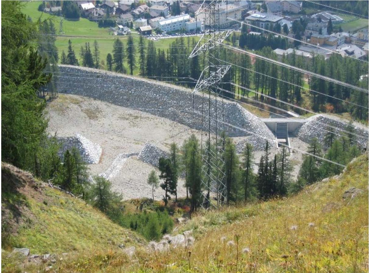
Abb. 8: Kombiniertes Murgang- und Lawinenauffangdamm mit integrierter Murgangbremse oberhalb von Pontresina.
