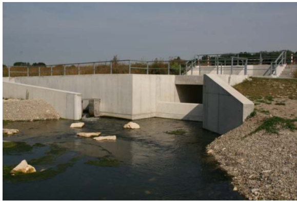
Abbildung 1: Ausleitungsbauwerk aus dem Dynamisierungsprojekt in den Donauauen zwischen Neuburg und Ingolstadt
