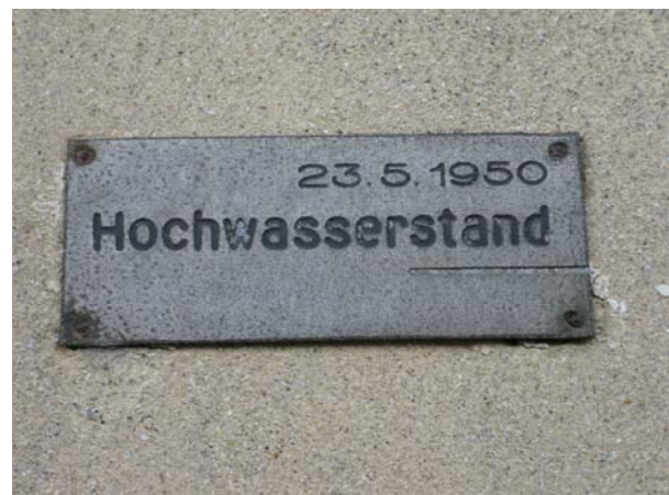
Abb. 2: Hochwassermarke an einem Wohnhaus (Foto: M. Deutsch)
