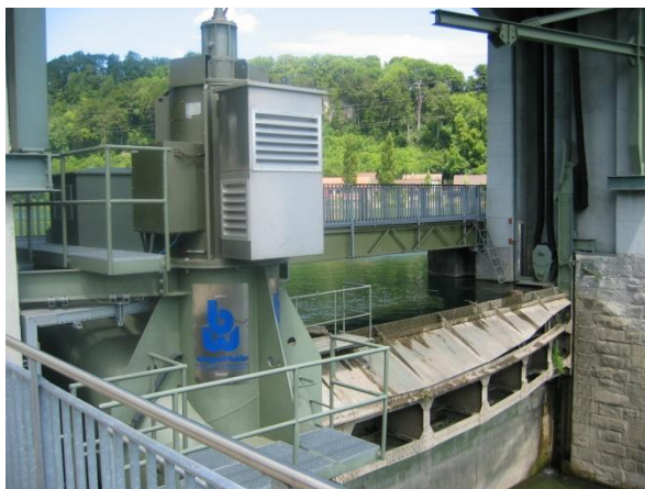
Bild 1: Wasserkraftwerke verwenden die Abflussvorhersagen für die Planung des Betriebs, insbesondere bei Hochwasser. Das Stauwehr Winznau reguliert den Zufluss der Aare zum Oberwasserkanal des Laufkraftwerkes Gösgen. (Foto: Bruno Schädler)
