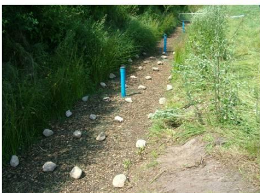
Abbildung 1: Dränagerohreinlass in einen Dränageteich (oben) und ein mit Holzhackschnitzel befülltes reaktives Grabensystem (unten) im Einzugsgebiet der Kielstau (LLUR 2010).
