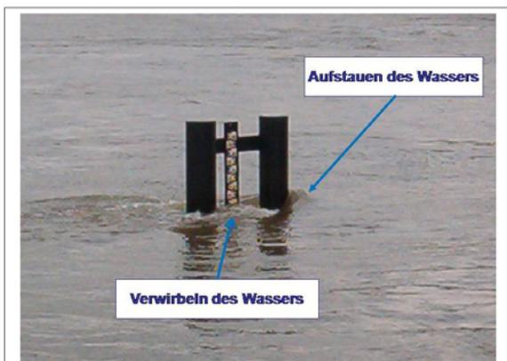
Bild 3: Aufstauen und Verwirbeln des Wassers am Wasserstandsanzeiger Hohnstorf/Elbe beim Hochwasser im April 2006
