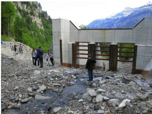
*Ausleitbauwerk und Geschieberückhalt. Hochwasserschutzmassnahmen am Glyssibach, Schwanden bei Brienz (Foto: Viviroli 2011)*
