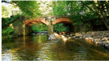
Sohlrampe der Stepenitz bei Telschow
