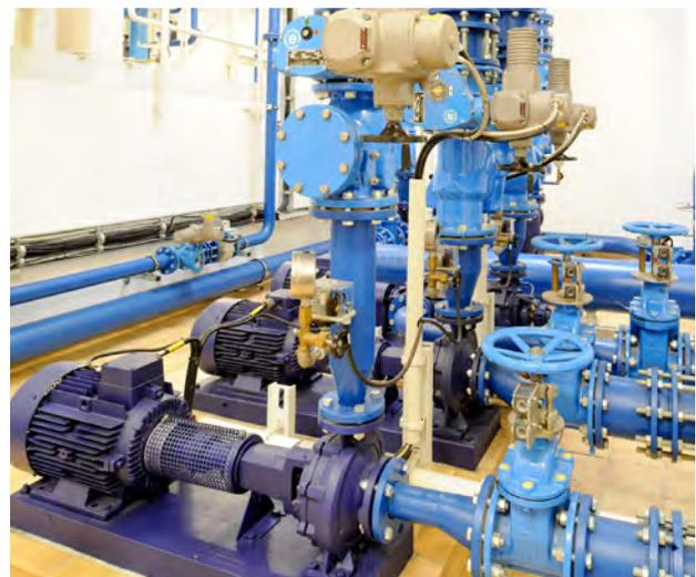
Kreiselpumpen zur Förderung des Trinkwassers bis zum Verbraucher
