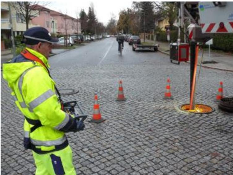
Reinigungsarbeiten mit sicherem Abstand (Quelle: BWB)
