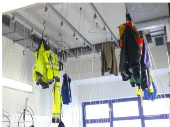
Beispiele: Stiefel Trocknungsvorrichtung, Aufbewahrung von Arbeitskleidung (Bergmannslösung)
