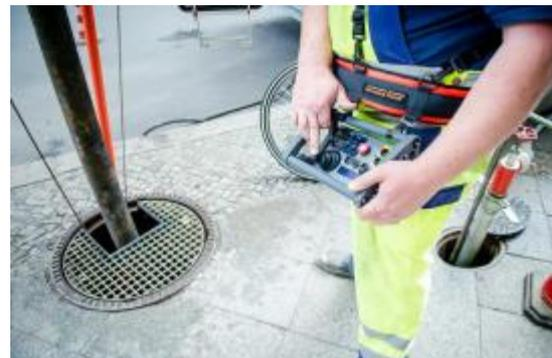
Beispiele: Hochdruckkanalspülung mit Fernbedienung (Quelle: WSW, BWB)
