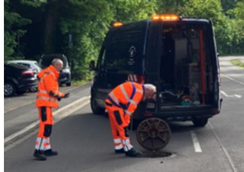
**Arbeits- und seitlicher Sicherheitsbereich von Fahrzeug abgedeckt**
