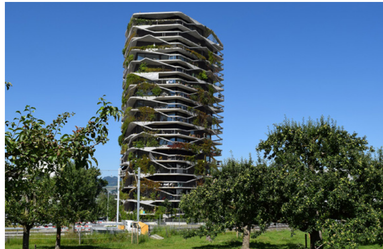
Vertikale Gebäudebegrünung © Bundesverband Gebäudegrün e. V.
