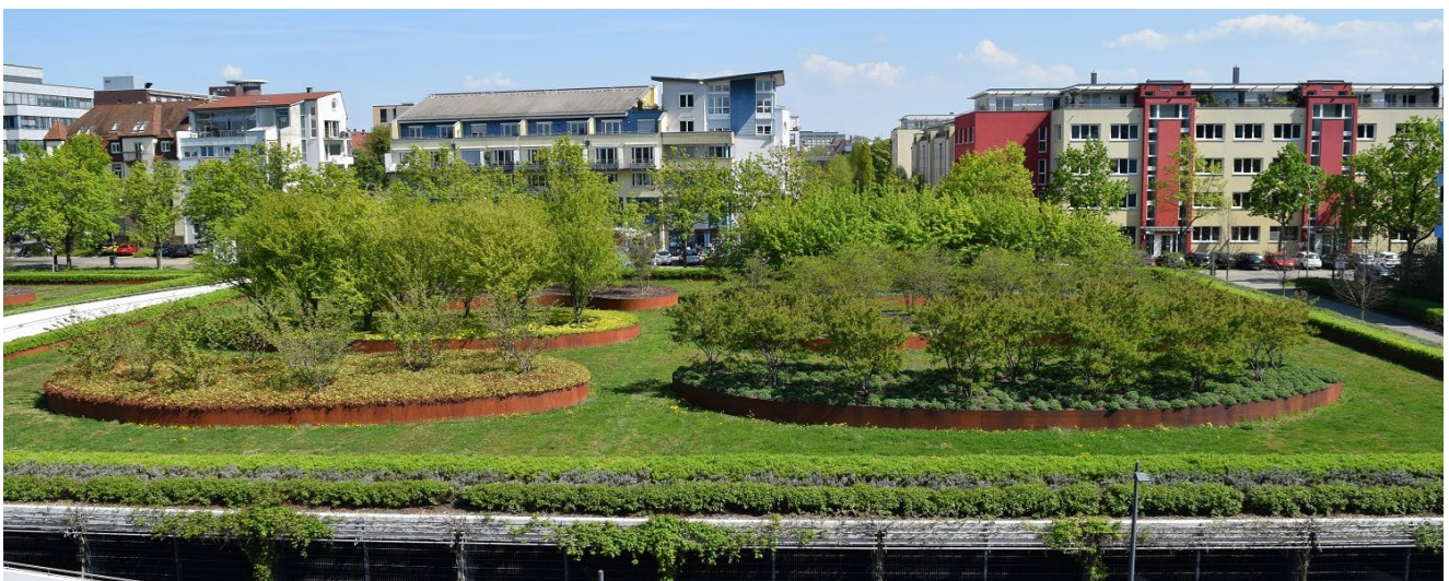
Dachbegrünung Parkhaus, Karlsruhe © Bundesverband Gebäudegrün e. V.
