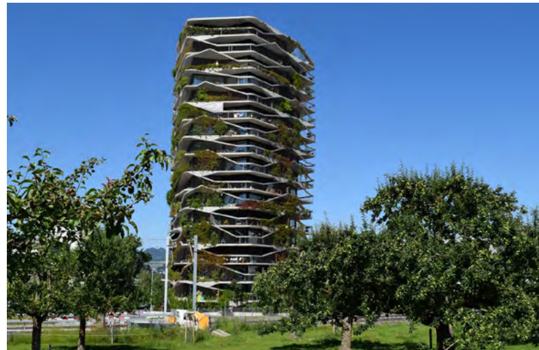
Vertikale Gebäudebegrünung © Bundesverband Gebäudegrün e. V.
