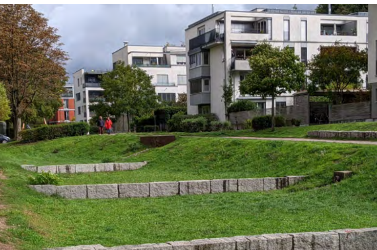
Mulden-Rigolen-Versickerung, Freiburg © Eva Geelen
