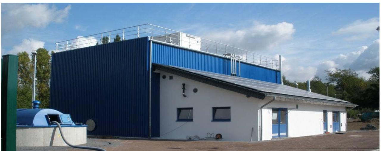
Bild 30: Kompaktfaulungsanlage auf der Kläranlage Linz-Unkel
