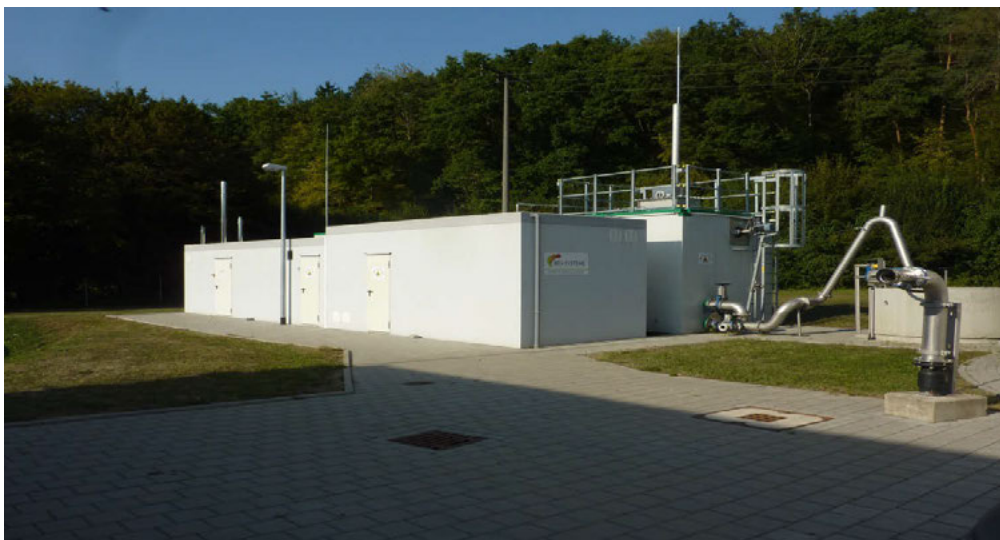
Bild 3: Einstufige modulare Kompaktfäulung der KA Steinfeld-Hausen
