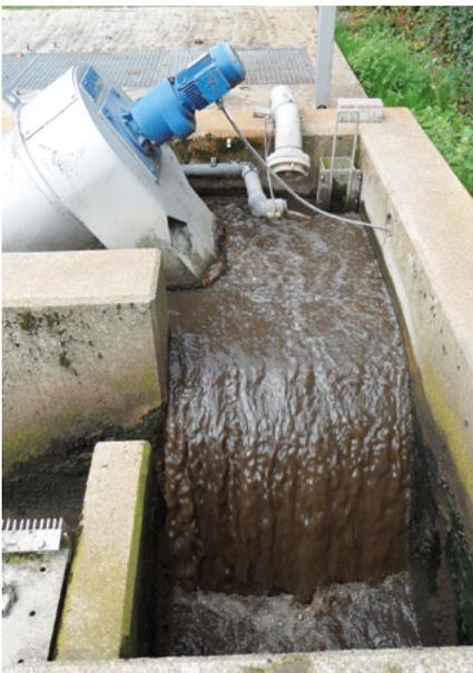
Abb. 7: Perfekte Dosierung Rücklaufschlammschnecke
