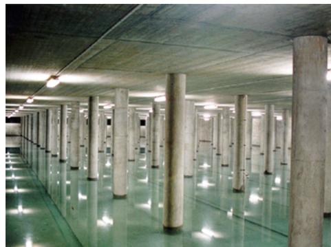
Abb. 14: Gigantisch! In diesem **Regenrückhaltebecken** unter einem Parkplatz können bis zu 90 000 m<sup>3</sup> Mischwasser gespeichert werden.
