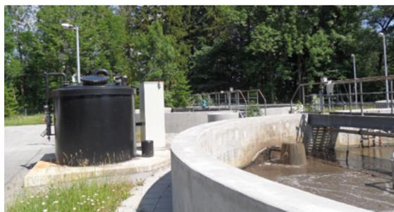
Abb. 10: Stabilisierungsbecken mit dazwischen angeordneter Tankanlage
