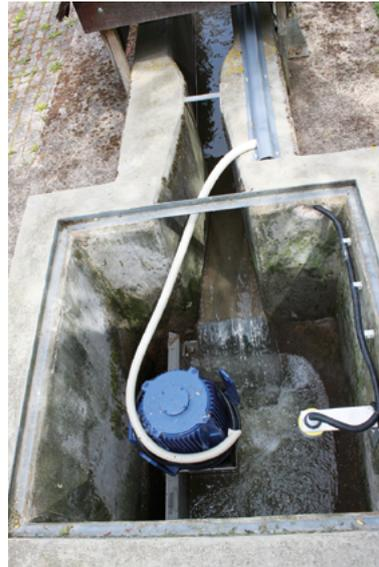
Abb. 4: Eine Ultraschall-Füllstandsmessung (rechts an der Schachtwand) schaltet den Zerkleinerer abhängig vom Wasserstand ein und aus.
