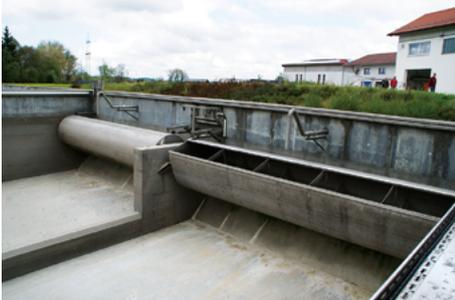
Abb. 9: Eine andere Art zur Verminderung von Ablagerungen auf der Beckensohle sind Spülkippen, die, kurz bevor das **Regendurchlaufbecken** wieder entleert ist, mit einem Schwall die Grobstoffe zum Ablauf zur Kläranlage befördern.
