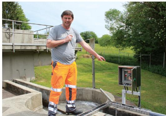
Abb. 2: Am Schacht gestattet es ein Schaltschrank, den Zerkleinerer manuell zu starten und zu stoppen. Die gesamte Steuerung ist in den bestehenden Schaltschrank und damit in die zentrale Leitwarte integriert. Ein Display zeigt die Kennwerte wie die Anzahl der Starts, Reversierungen und die Laufzeiten aus den acht Wochen seit Inbetriebnahme.
