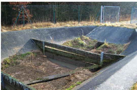
Abb. 3: War der Sommer so trocken, dass sich bei diesem **Regenrückhaltebecken** so ein Bewuchs bilden konnte oder wurden die Ablagerungen lange Zeit schon nicht mehr entfernt? Man braucht wenig Fantasie, um zu ahnen, was beim nächsten Starkregen passiert.
