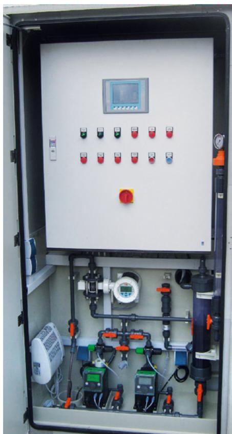
Abb. 11: Dosieranlage für ein Stabilisierungsbecken
