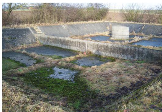
Abb. 5: Endlich ein betoniertes **Regenrückhaltebecken**, da ist doch die Wartung viel leichter. Aber auch da gilt die alte Weisheit: Der Zahn der Zeit – ohne Wartung holt sich die Natur wieder alles zurück.
