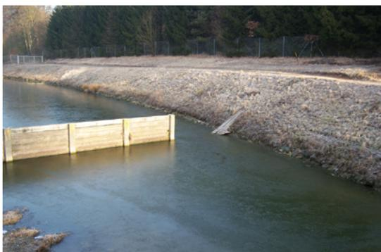
Abb. 1: Die Trennwand sollte bei diesem **Regenklärbecken** dafür sorgen, dass Schmutzstoffe aus dem Regenwasser zurückgehalten werden und nicht ungehindert ins Gewässer gelangen.
