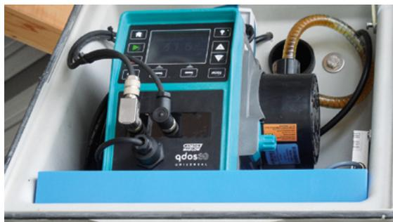
Abb. 9: Schlauchdosierpumpe über Tank
