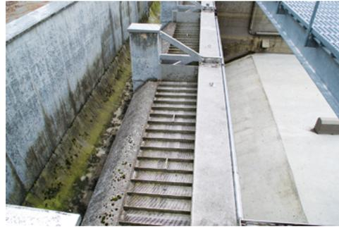
Abb. 11: Bei diesem **Regendurchlaufbecken** verhindert ein Sieb beim Klärüberlauf die Einleitung von größeren Stoffen ins Gewässer.
