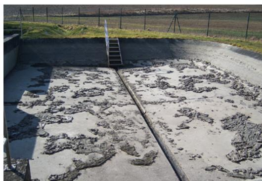
Abb. 6: Dies ist ein **Regendurchlaufbecken**, das viel häufiger beaufschlagt wird. Doch auch hier sollten die Ablagerungen schnellstens vor dem nächsten Niederschlag entfernt werden, sonst „entfernt“ der nächste Regenguss die Stoffe ins Gewässer. Hier fehlt auch ein Sicherheitsgeländer.
