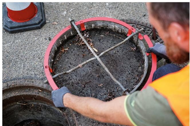
Abb. 2: Montieren des Halbrings auf dem Schmutzfangkorb
