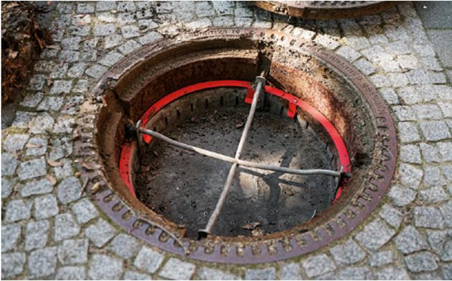
Abb. 3: Halbring, fertig nachgerüstet und eingebaut
