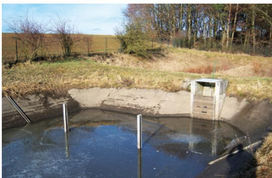
Abb. 2: Es geht noch besser. Warum nicht gleich die ganze Trennwand weg? Bei diesem **Regenklärbecken** können keine Schwimmstoffe mehr zurückgehalten werden.
