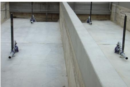
Abb. 8: Dieses **Regendurchlaufbecken** besitzt als Spüleinrichtung Strahlreiniger, die nach Abklingen der Überlaufphase einsetzen, damit die absetzbaren Stoffe in Bewegung bleiben und zum Kläranlagenzulauf gebracht werden.
