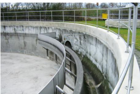
Abb. 10: Der Klärüberlauf eines **Regendurchlaufbeckens** mit Tauchwand und auch mit Geländer, was unbedingt zur Sicherheitseinrichtung gehört.
