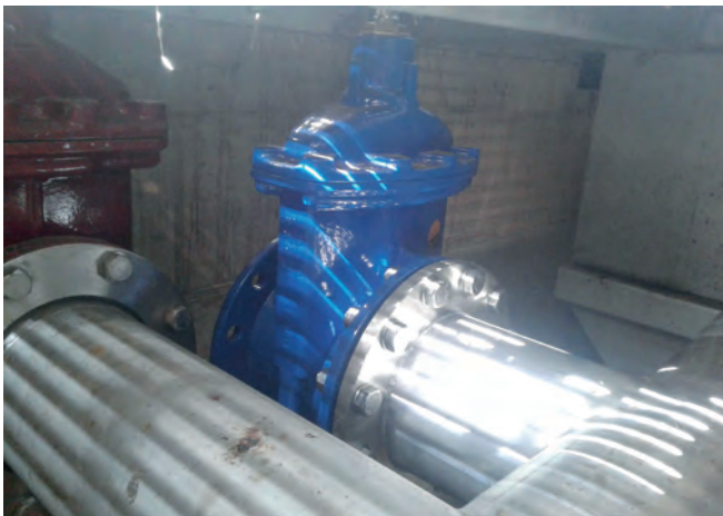
Abb. 3: Die fertige Bypass-Leitung mit dem blauen Schieber
