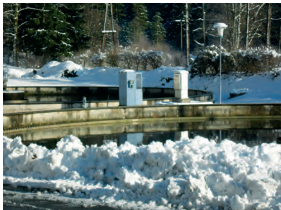
Abb. 16: Hier beginnen die Räumarbeiten.
