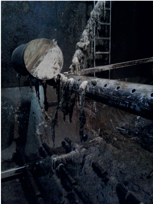
Abb. 6: Verzapfungen nach 20-jährigem Betrieb
