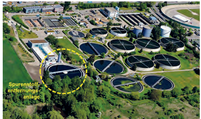
Abb. 1: Luftbild der Kläranlage Böblingen-Sindelfingen
