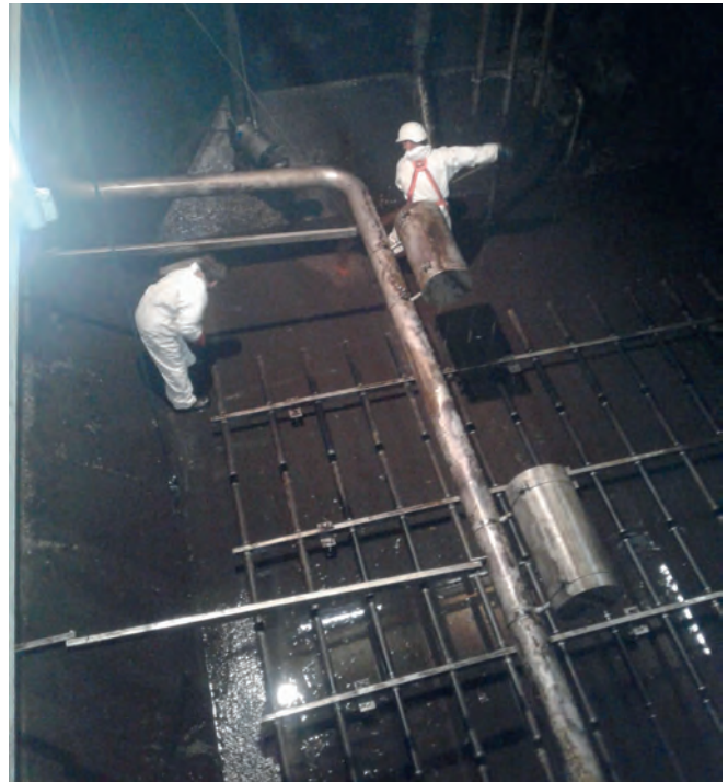
Abb. 5: Reinigen des Bioreaktors
