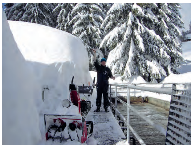
Abb. 6: Nur mit großem Einsatz kann das Belebungsbecken noch freigehalten werden.
