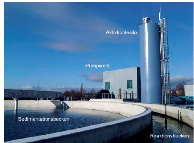
Abb. 6: Pumpwerk, Aktivkohlesilo, Reaktionsbecken und innenliegendes Sedimentationsbecken
