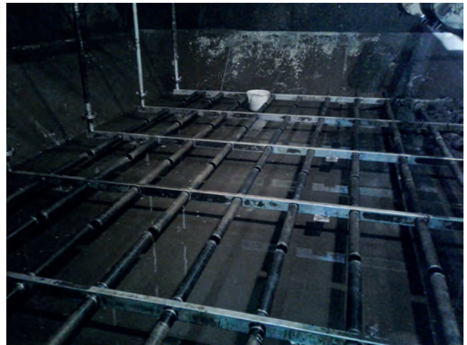
Abb. 7: Einbau der neuen Stangenbelüfter
