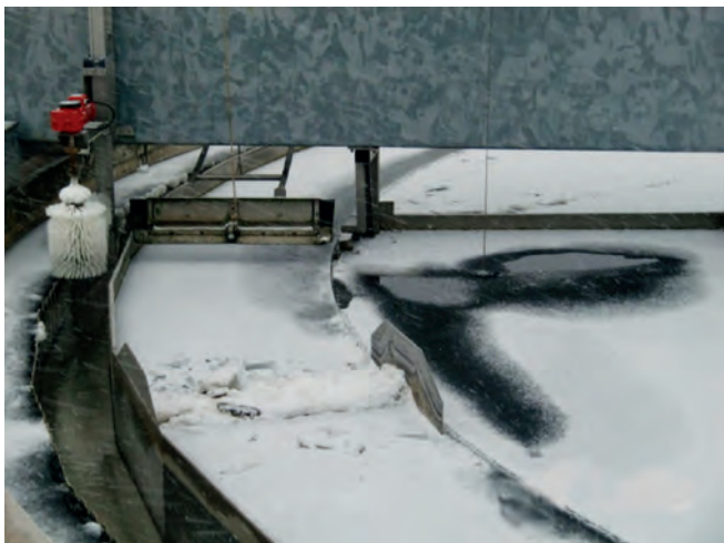
Abb. 13: Hier haben Schwimmschlamm und Reinigungsbürste Pause.
