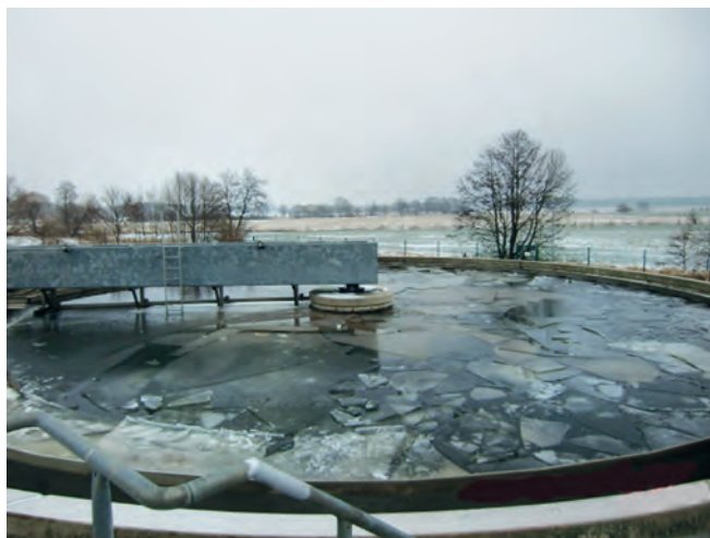
Abb. 10: Hier stößt der Räumler des Nachklärbeckens an seine Grenzen. Ohne die tatkräftige Arbeit des Betriebspersonals wäre der Räumler am Ende – womöglich sogar mit Materialschaden.
