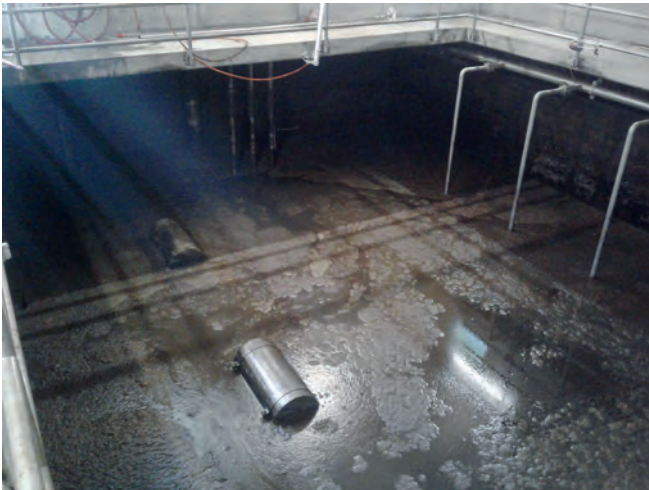
Abb. 4: Absenken des Inhalts im Bioreaktor
