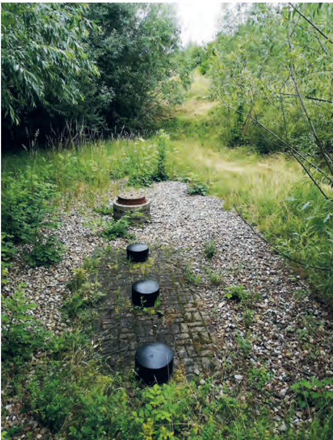
Abb. 4: Rigolen-Revisionsschacht am Weidigtbach vor der Zerstörung
