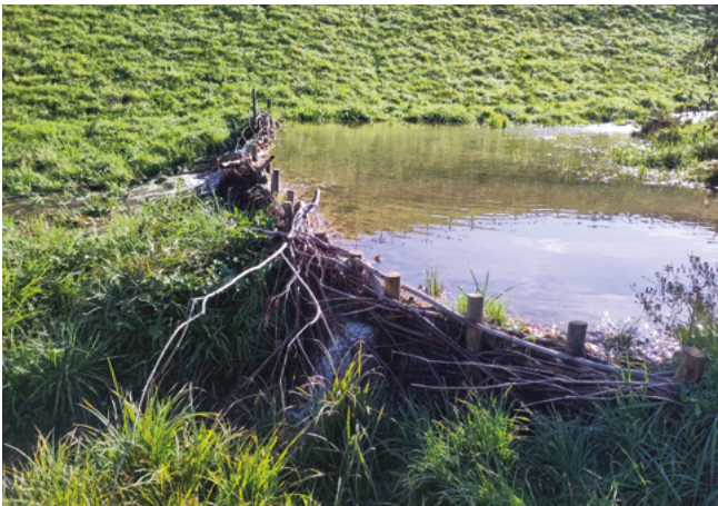
Bild: 4 Beaver Dam Analog in Funktion, Projekt Schlossbach. Nahaufnahme eines Einstaubereichs. In flacherem Gelände können relativ große Einstau- wie auch Zwischenbereiche geschaffen werden. (Foto: N. Werdenberg).
