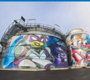
Abwasserbehandlung in der Tesla Gigafactory Berlin-Brandenburg Seite 806
