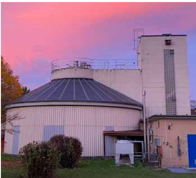
Faulturm Kläranlage Melsungen
