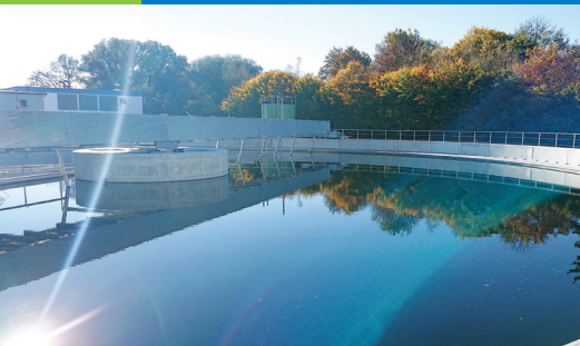
Kläranlage Freising, Bayern
