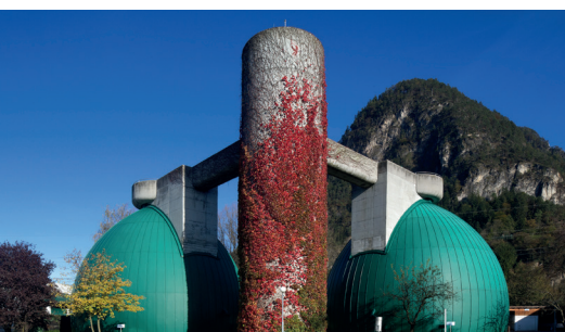
Kläranlage Strass i.Z., Tirol
