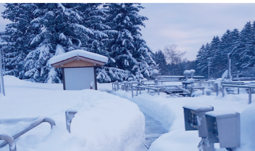
Kläranlage Holzkirchen, Bayern
