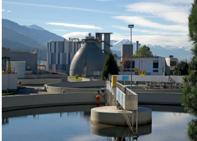
Kläranlage Fritzens (A)
