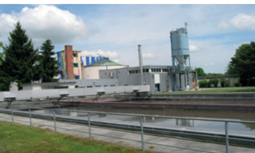
Kläranlage Neuburg a.d. Donau
